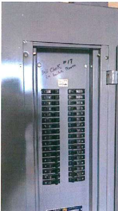
Photo E15 Panel D – Office 203
